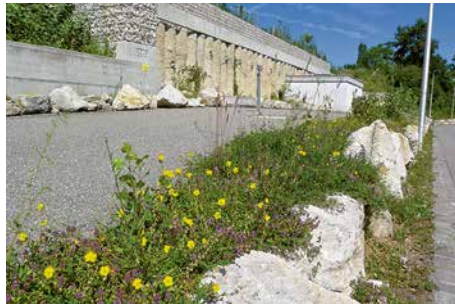
Als Trockenstandort begrüntes Mischwasserbecken
