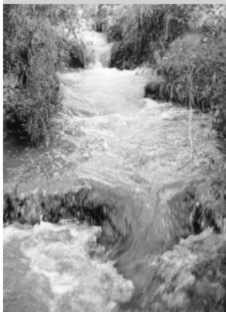
Umgehungsgerinne/Fischaufstieg beim Wehr Nenzlingen an der Birs. (Foto: Felix Berchten)
