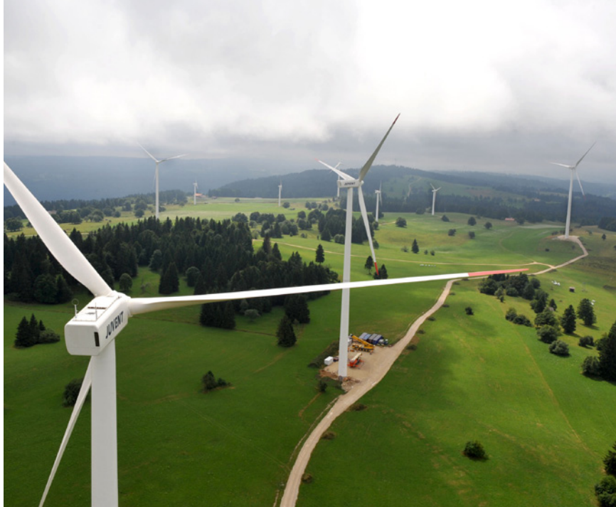
Der Windpark zwischen Mont-Crosin und Mont-Soleil im Berner Jura ist die bisher grösste Windkraftanlage der Schweiz.
