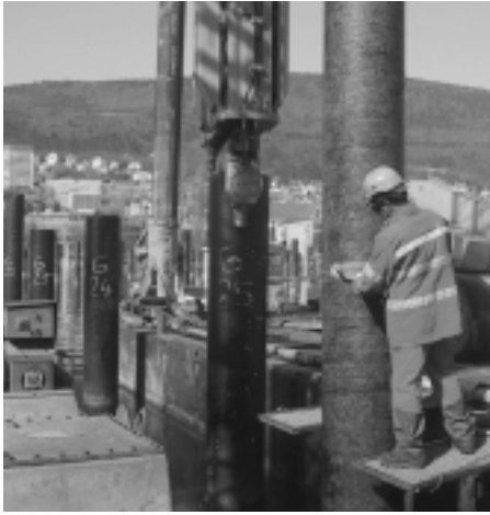
A gauche: «precycling» à l'instar des pieux extraits à Neuchâtel. Déjà d'occasion, ils ont encore été réutilisés après Expo.02. A droite: les machines de chantier ont été équipées de filtres à particules (Photos: A. Stuber).
