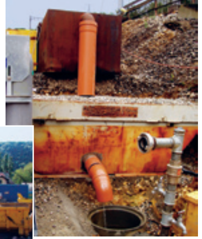
Bennes de récupération des terres excavées avec la distinction des terres polluées dans la benne rouge – «la benne qui pue!»
