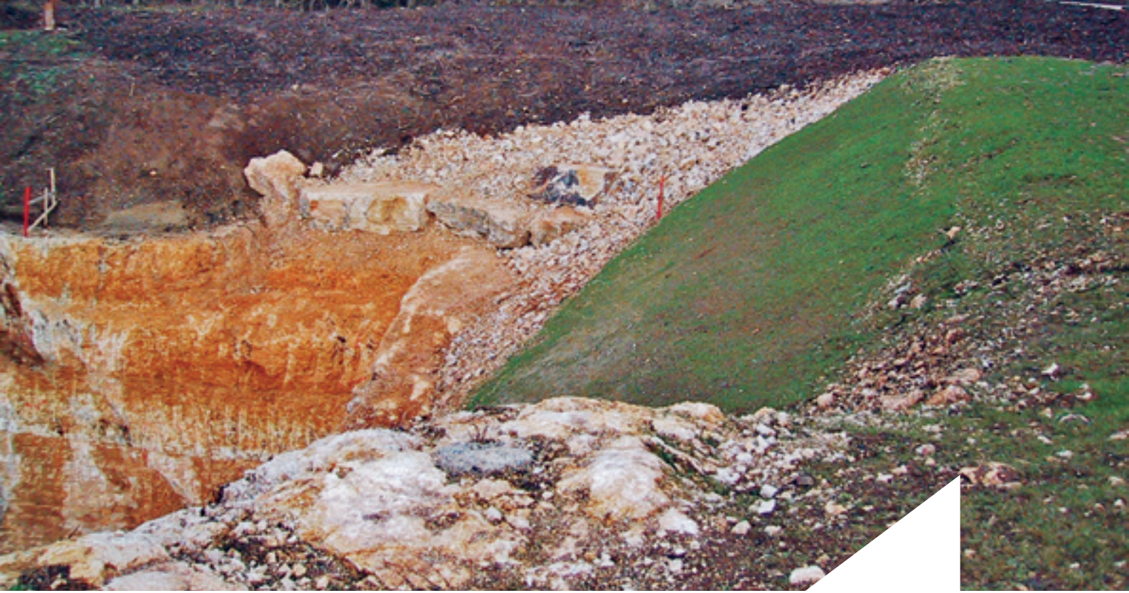
Réaménagements en faveur de la nature, au sommet du portail d'Eclépens, peu après la fin des travaux.
