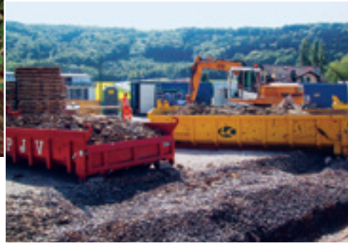
Bennes de récupération des terres excavées avec la distinction des terres polluées dans la benne rouge – «la benne qui pue!»
