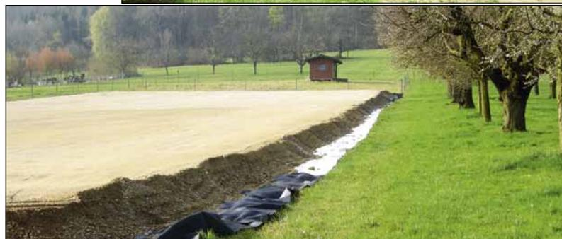
Place d'installation d'un chantier: une épaisse couche de grave protège le sol fertile de ce terrain agricole.
