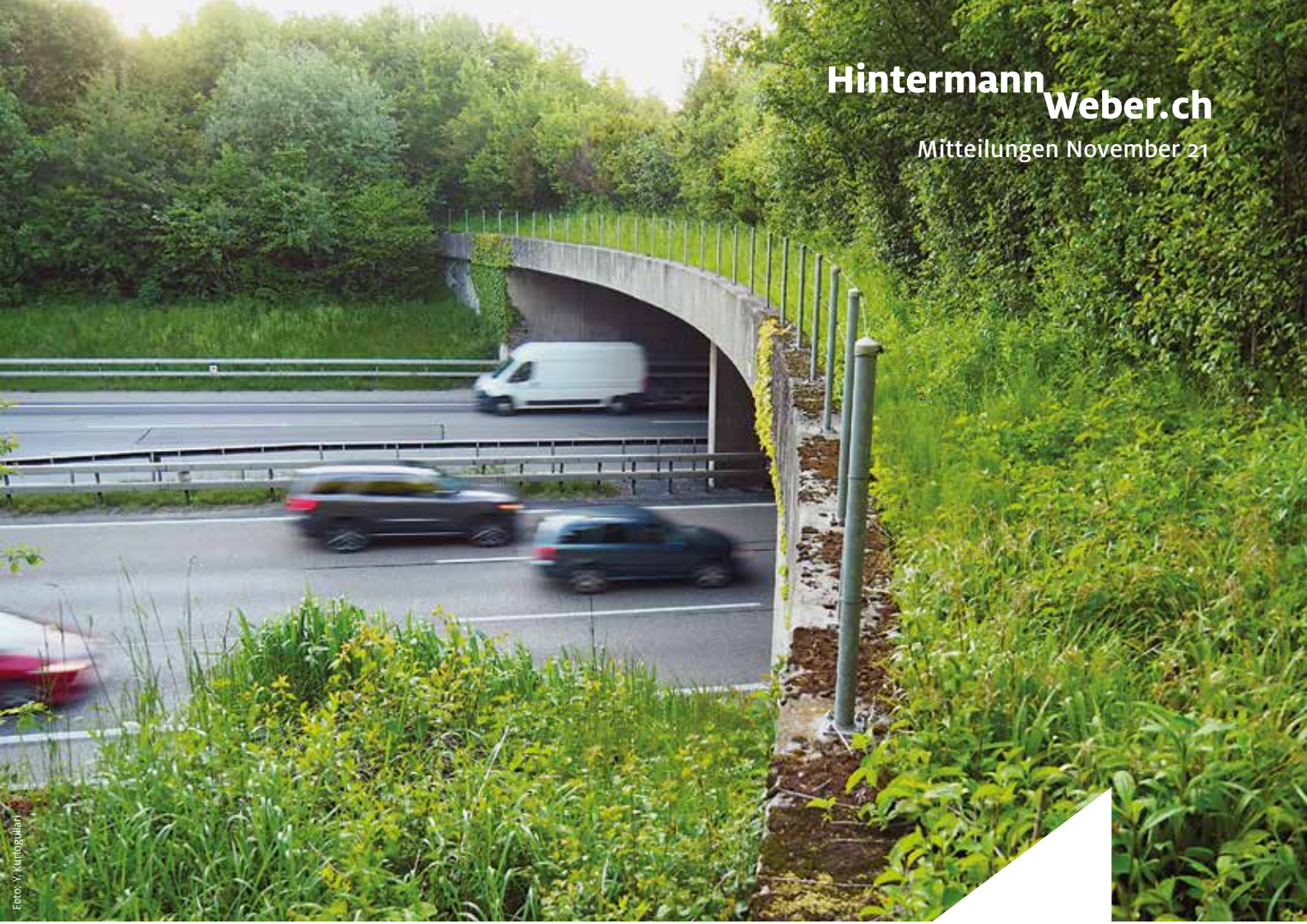
Wildtierbrücke über die A1 bei Zollikofen.
