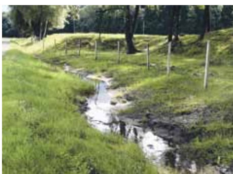
Après les travaux
