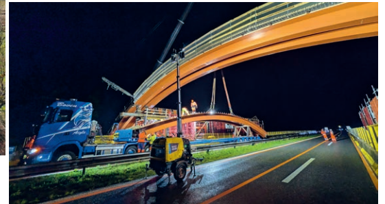
Début avril 2026, après de longs travaux discrets de part et d'autre de l'autoroute pour la réalisation des culées, le passage prend forme. Durant les nuits du 13 au 18 avril, les éléments de l'arche sont déposés petit à petit, après la fermeture nocturne de l'autoroute.
