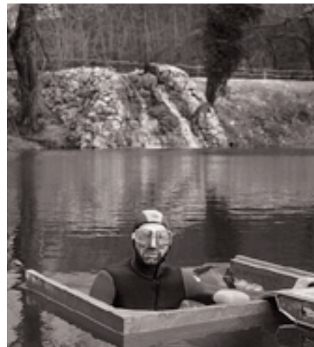
H&W-Taucheinsatz im engen Betonschacht. (Foto: Stefan Berchten)
