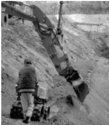
Links: Einbau der Abdichtung am 120 Meter langen Damm des mittleren Ermitageweihers. (Foto: Werner Keller). Rechts: Die für die Schweiz einzigartige englische Gartenanlage wurde 1785 im Auftrag der Frau des fürstbischöflichen Landvogts, Balbina von Andlau, erstellt. (Foto: Felix Berchten)
