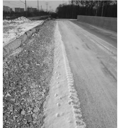
Grünbrücken (hier im Bau) sollen die Trennwirkung des Autobahnzubringers N3-A98 für Wildtiere vermindern. Ob die aufwändigen Bauwerke effektiv benutzt werden, ist erst zu prüfen. Zumindest ein Hase hat den angebotenen Weg jetzt schon gefunden (Foto: P. Ramseier).
