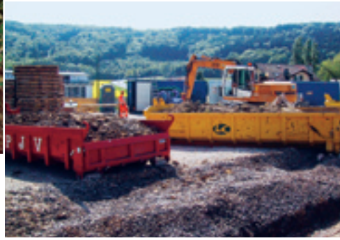
links: Getrennte Mulden für unterschiedliches Bodenmaterial. Die rote Mulde enthält verschmutztes Erdreich.
