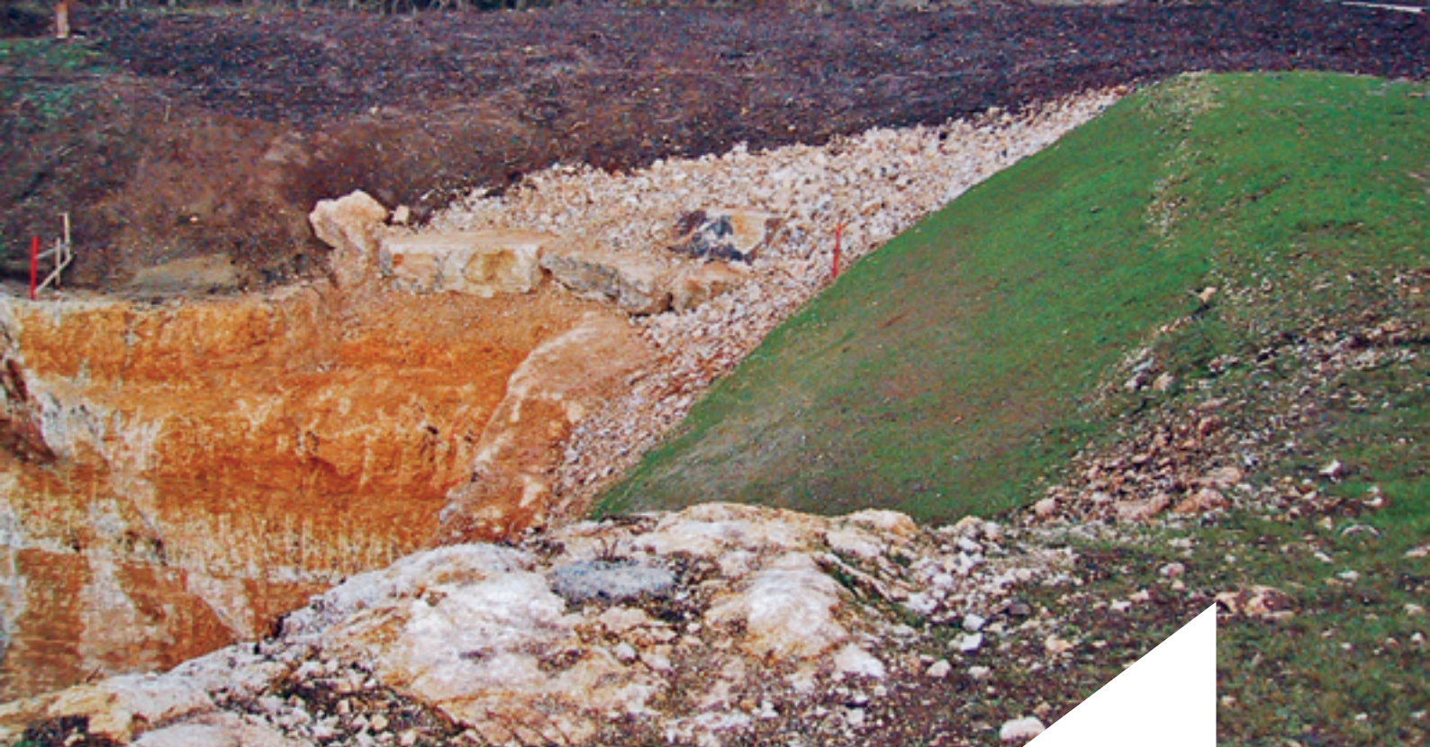
Naturfreundliche Gestaltung des Tunnel-Portals bei Eclépens unmittelbar nach Abschluss der Bauarbeiten.
