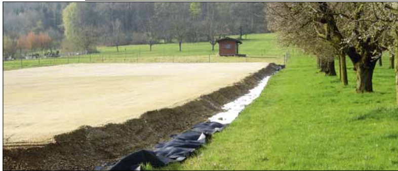
Installationsplatz für eine Baustelle: eine dicke Schicht Schotter schützt den fruchtbaren Landwirtschaftsboden.
