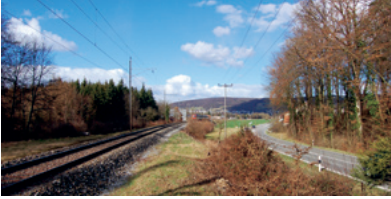
Près de Böttstein (AG), situation initiale: Les CFF et la route cantonale interrompent un corridor à faune.
