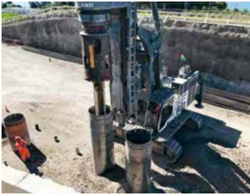
Une foreuse de 110t prépare les assises de la tranchée couverte de la ligne CFF à Lutry.
