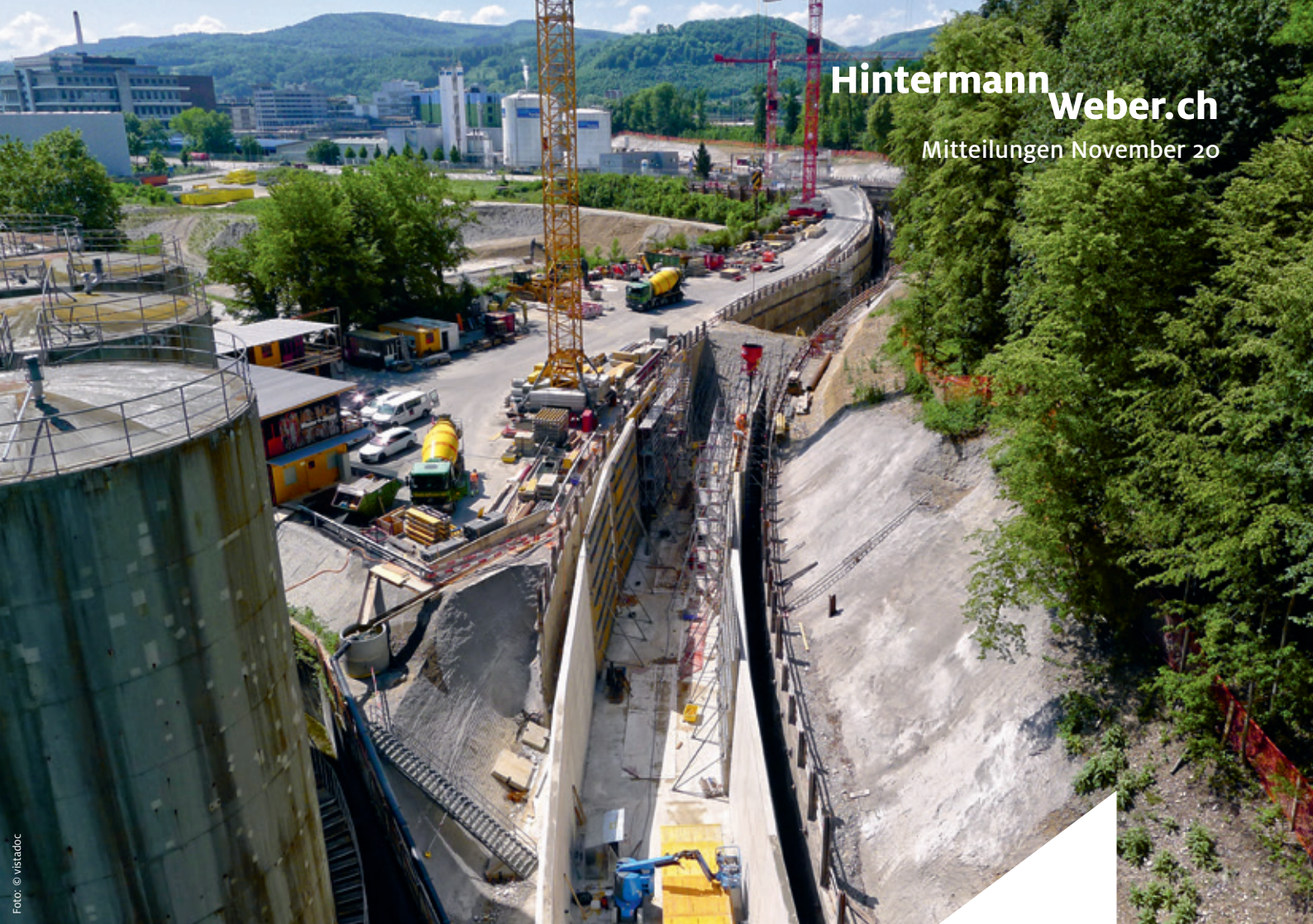
Arbeiten an der «schwarzen Wanne» im nördlichen Teil der Baustelle.
