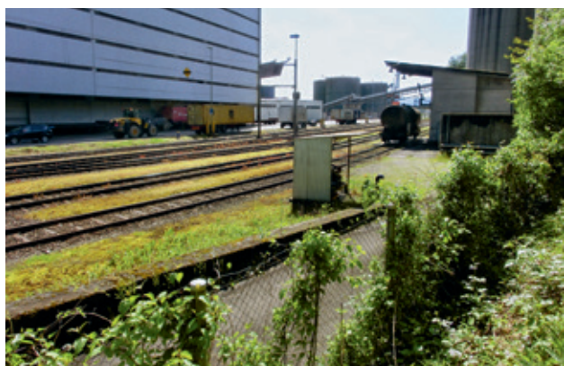
Bestehende Bahnanlagen im Auhafen.
