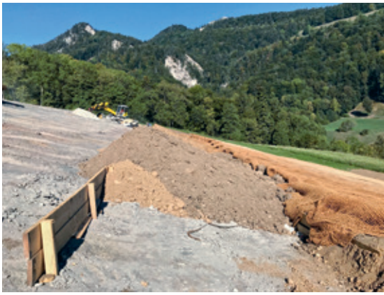
Stabilisierung des geschütteten Materials durch hangparallele Bretter und Geotextilien.
