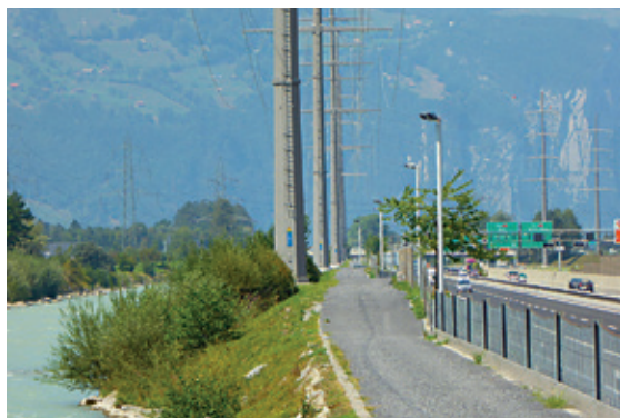
Neue Leitungen werden wenn möglich entlang bestehender Infrastrukturen geführt.
