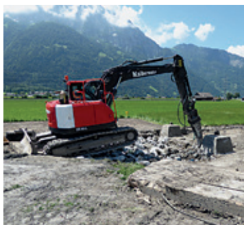
Rückbau eines alten Mastfundaments mit schwerem Gerät.
