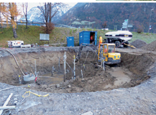
Baustelle für einen neuen Masten. Die Fundamente und ihre Verankerung können mehr als 10 m in den Boden hinein reichen.
